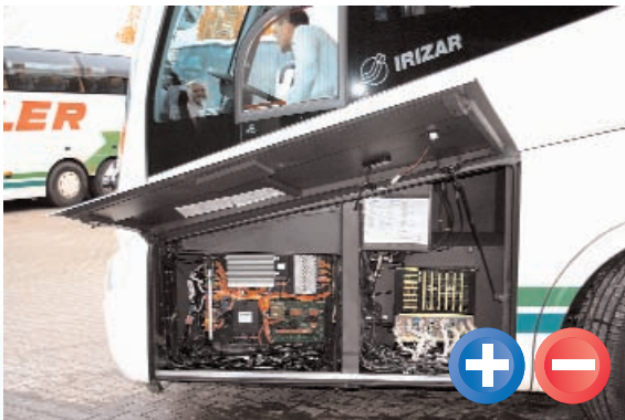
Die Elektronik des Irizar PB befindet sich unter dem Fahrerarbeitsplatz.
