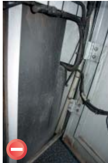
- Der Kunststofftank ist nur mit einer senkrechten Vierkantstrebe gesichert, durch den ungesicherten, freien Raum drückt sich der Tank nach außen.
